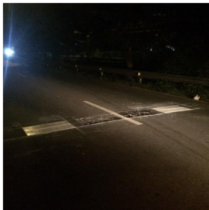
รูปที่ 4.34 รูปถ่ายระหว่างการทำเครื่องหมาย “Transverse Bar” และการติดตั้งป้ายเตือน
