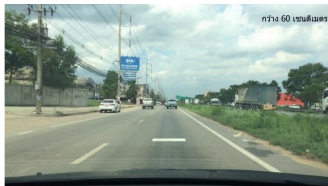
รูปที่ 4.22 การทดสอบติดตั้งเครื่องหมาย “Transverse Bar” ขนาด 1×0.6 เมตร
