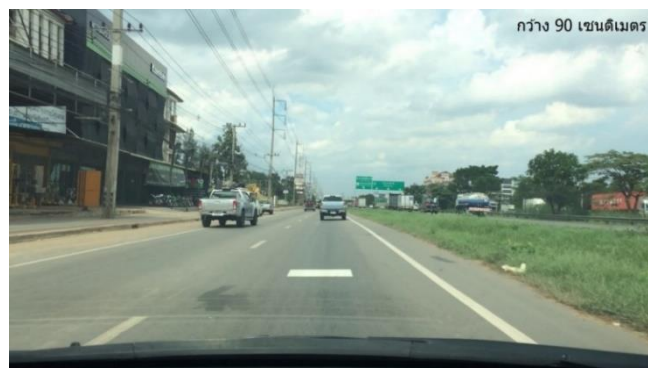
รูปที่ 4.23 การทดสอบติดตั้งเครื่องหมาย “Transverse Bar” ขนาด 1×0.9 เมตร
