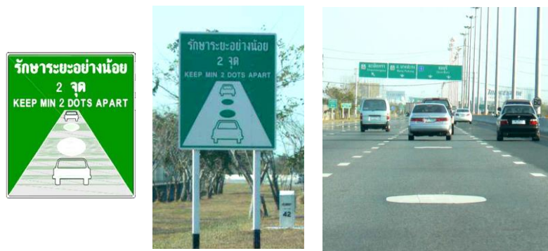
รูปที่ 2.7 การติดตั้งเครื่องหมายบนผิวจราจรแบบ “Dot” บนทางหลวงพิเศษหมายเลข 7 (ที่มา: อนินทิตา ปฏิสังข์, 2553)
