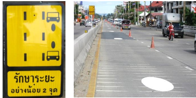
รูปที่ 2.6 การติดตั้งเครื่องหมายบนผิวจราจรแบบ “Dot” บนทางหลวงหมายเลข 1141 (ที่มา: พลเทพ เลิศรวนิช, 2553)
