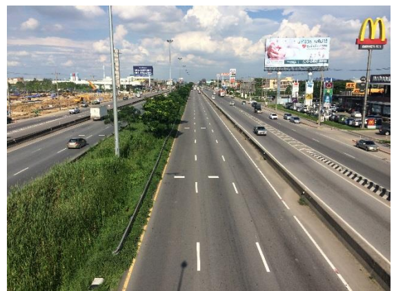
รูปที่ 4.35 รูปถ่ายหลังการทำเครื่องหมาย “Transverse Bar” และ การติดตั้งป้ายเตือน เรียบร้อยแล้ว
