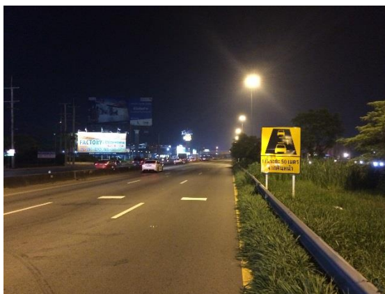
รูปที่ 4.35 รูปถ่ายหลังการทำเครื่องหมาย “Transverse Bar” และ การติดตั้งป้ายเตือน เรียบร้อยแล้ว
